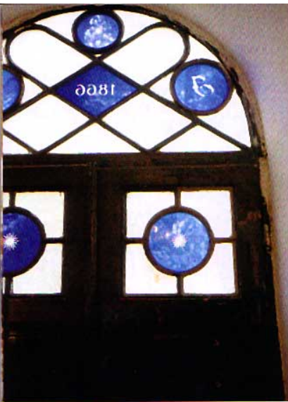
太陽の光を受けてブルーがきらめく ステンドグラスがはめ込まれた扉。 この出入口は今は使われていない。
